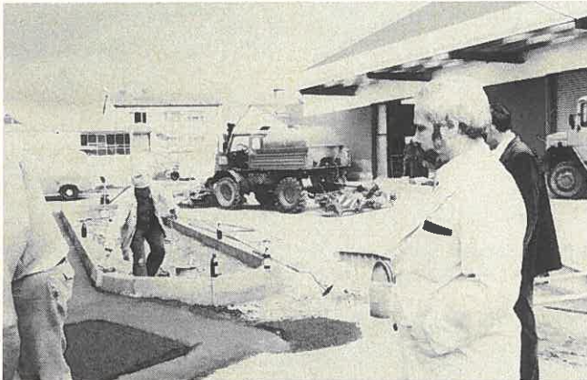
Kritisch betrachtet Firmenchef Eberhard Richter den Bau der Haltestelleninsel, an der der Tw 819 Aufstellung finden soll.
