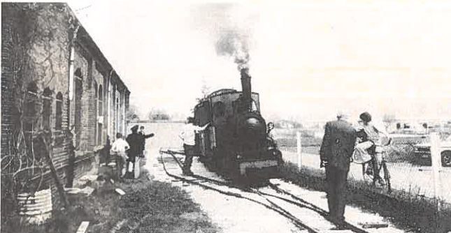
DGEG-Viernheim: Der Verein Dampfbahn Rhein-Main veranstaltet seit Ostern 1979 Dampffahrten auf 600-mm-Feldbahnspur im RNEM. Das Bild zeigt das Umsetzen der Lok. Foto: DGEG/Kurt-Rudolf Bayer
