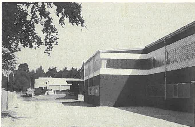
Rechts im Bild die neue Fabrikationshalle von E. P. Lehmann. Links im Hintergrund stehen die Museumsfahrzeuge der LGB-Fabrik. Foto: Robert Münzing
