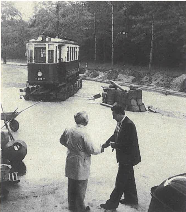
Museums-Tw 819 ist auf dem Fabrikgelände eingetroffen. Firmenchef Eberhard Richter vereinbart mit Direktor Bauer von der Nürnberger Feuerwehr den Auftrag zur Abladung des Straßenbahnwagens.
